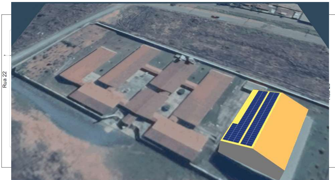
FIGURA 3 – ÁREA SUGERIDA PARA INSTALAÇÃO DO SISTEMA FV.
